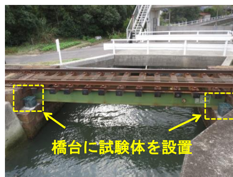
写真-2 物性確認試験体曝露状況
