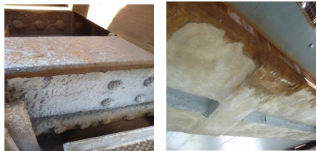
写真－4 外観調査(左；主桁上部 右；主桁下部)
