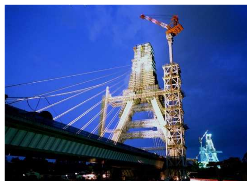
写真 2 深夜に及ぶ工事の状況
