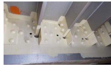
図-8 L型アングル材の設置状況
