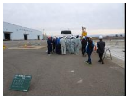
写真 3 港湾の建設現場見学
