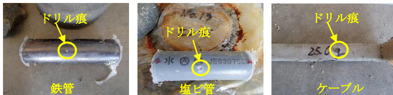
写真-2 埋設物の表面状況
