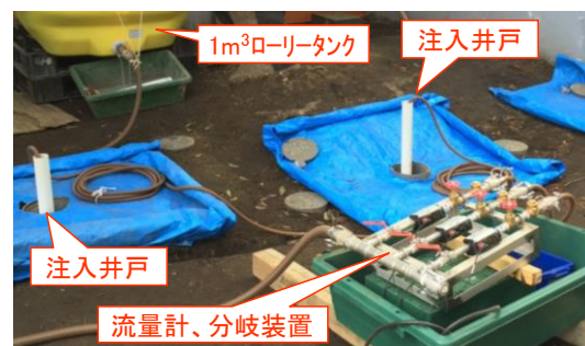
写真-1 FB 剤注入状況
