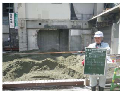
写真-4 民間のビル解体事業へ流用 (運搬 13km)
