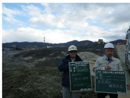
写真-1 寝屋川市の造成事業へ流用 (運搬 20km)
