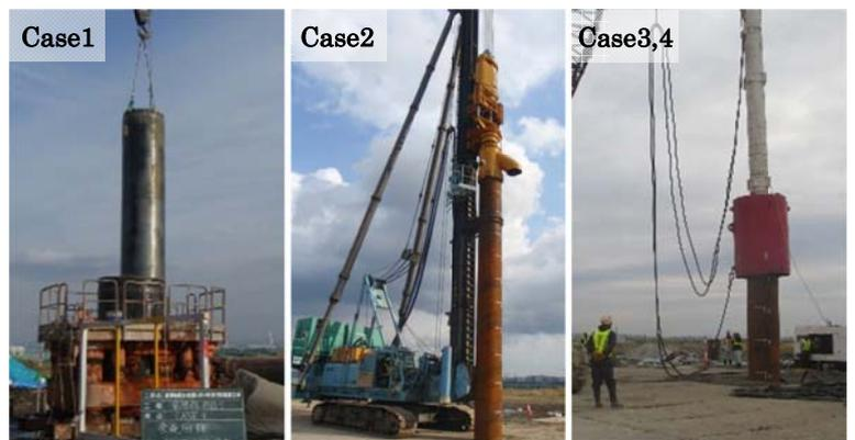
写真-1 試験杭打設状況
