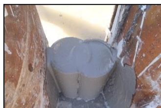
写真1 鋼管矢板継手部 (井筒形状)
