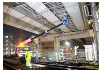
鉄道跨道橋の点検状況(軌陸車)
