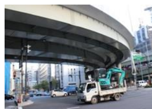
交差点跨道橋(江戸橋北交差点)
