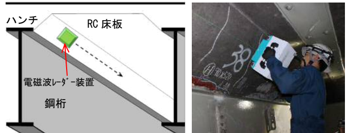
図-4 電磁波レーダー装置RC床版ハンチ部対向状況
