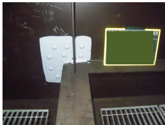
写真-3 当板補強（1層目塗布後）
