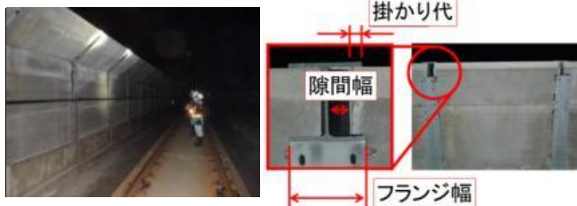
図-2 左)点検状況, 右)点検時の着目点
