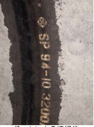
ロボットによる清掃後
