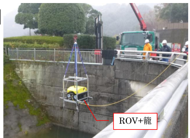
写真-1 ROV 投入状況
