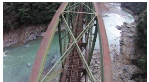
写真-4 トラス橋上弦材
