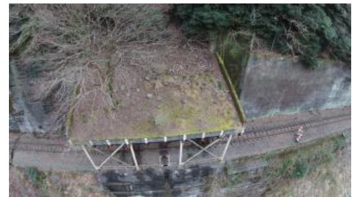
写真-3 落石覆い上部
