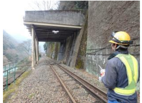
写真-2 ドローン操縦状況
