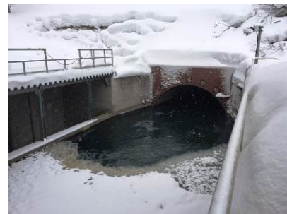
写真-1 導水路トンネル坑口(3月)
