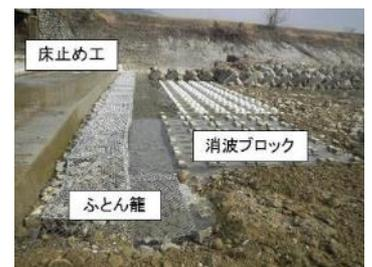
写真5 下流側対策工設置状況
