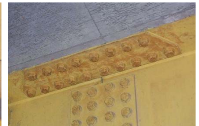
写真-6 上部添接板部
