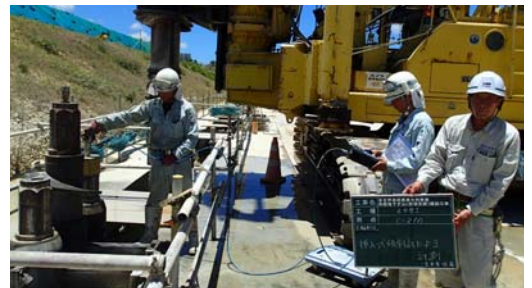
写真－2 挿入式傾斜計の計測状況
