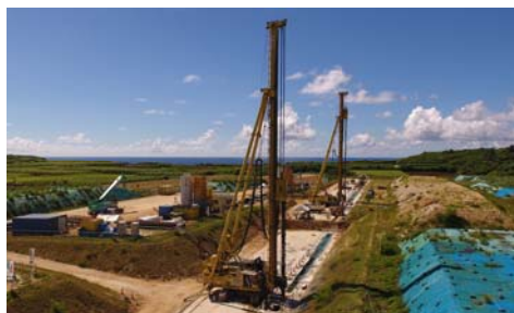
写真－1 施工状況
