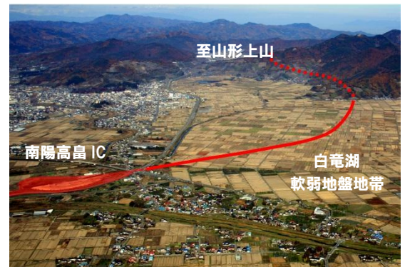
写真-1 現地状況写真
