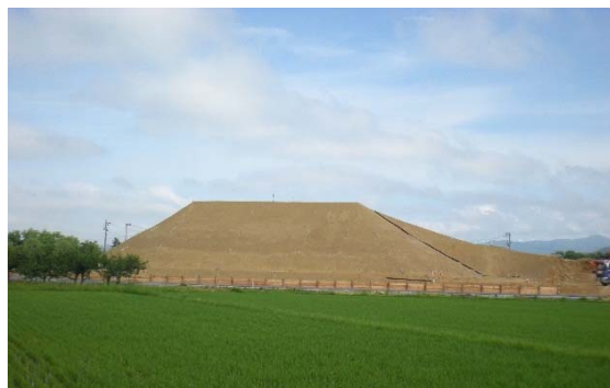
写真-2 載荷盛土完了（盛土厚さ約 14m）
