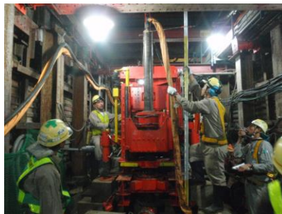
写真－1 路下削孔
