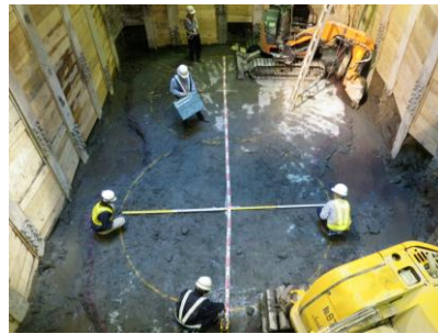
写真－3 試験施工
