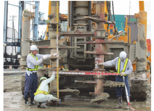
写真-1 \phi 1600 mm 2 軸 （CDM-EXCEED 工法）
