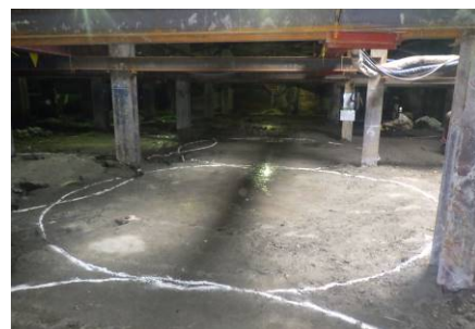
写真-3 改良体出来形
