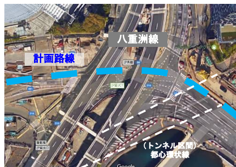
写真-1 現場上空写真
