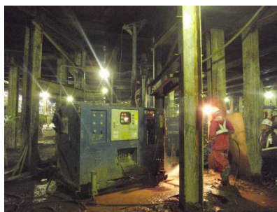
写真-2 施工状況
