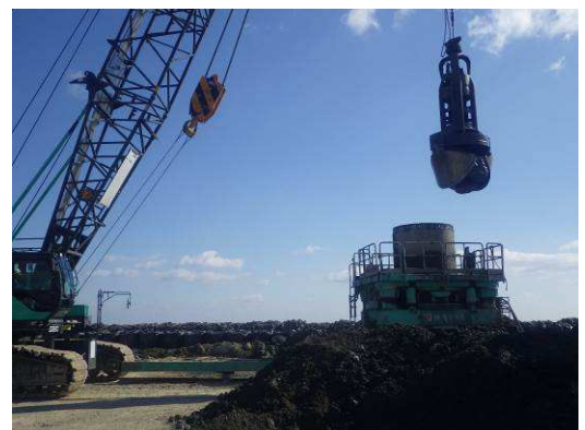
写真-2 障害物撤去状況
