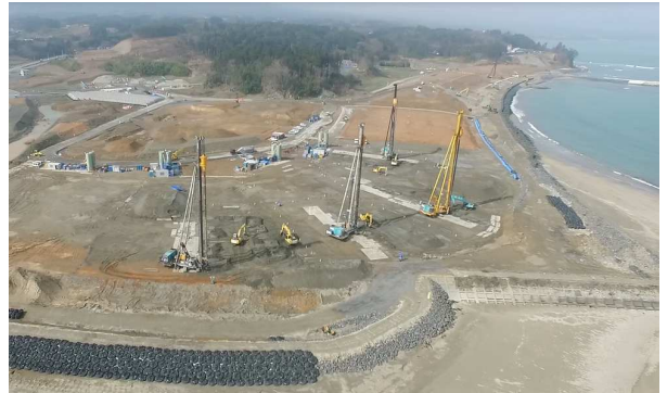
写真-1 現場全景
