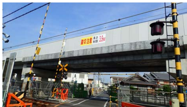
写真-5 H鋼埋込桁の施工完了状況
