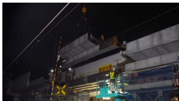
写真-3 架設状況（中央径間部）
