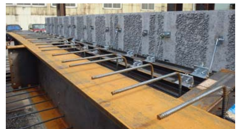
写真-2 工場での先組み状況
