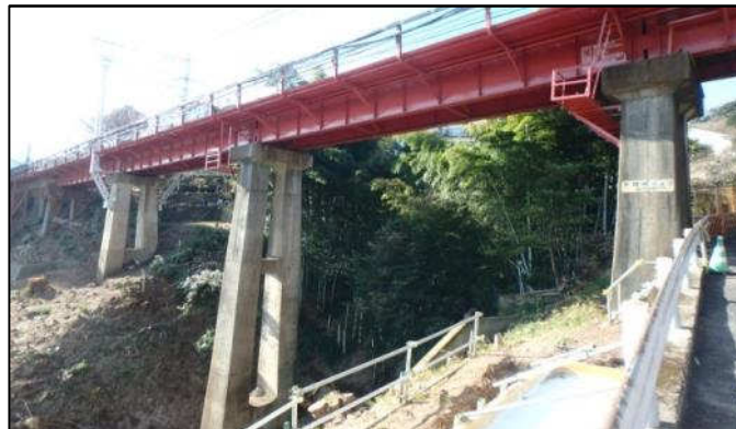
写真-1 施工前全景
