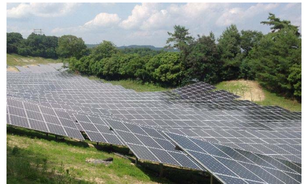
図-6 メガソーラー架台設置状況
