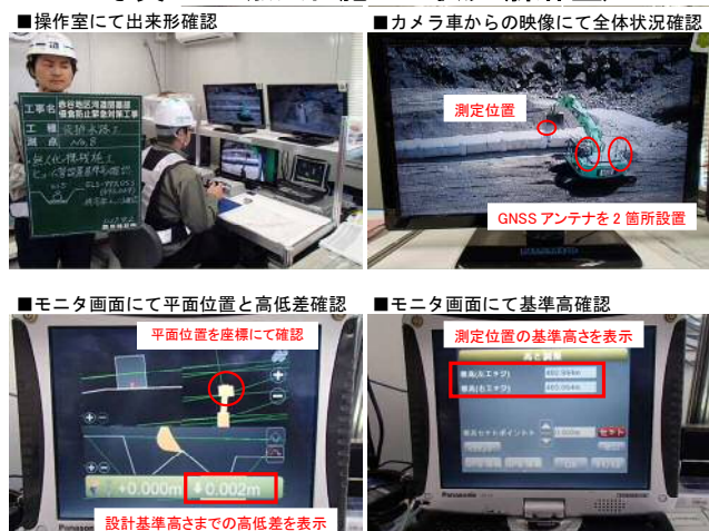
写真-3 出来形確認の状況(操作室)
