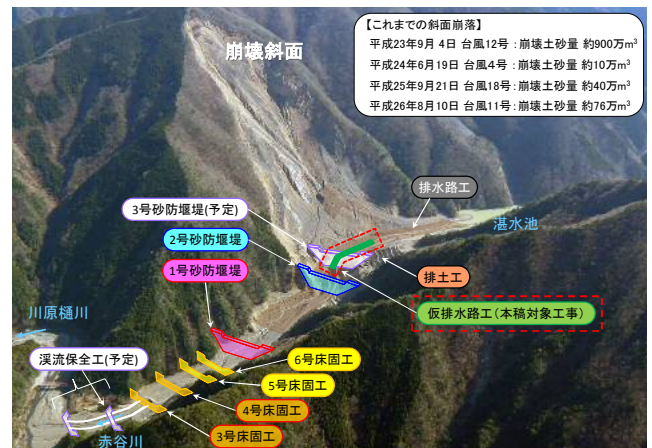
図-1 河道閉塞対策工事の全体概要
