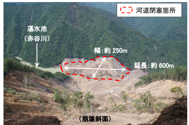
写真-1 河道閉塞状況
