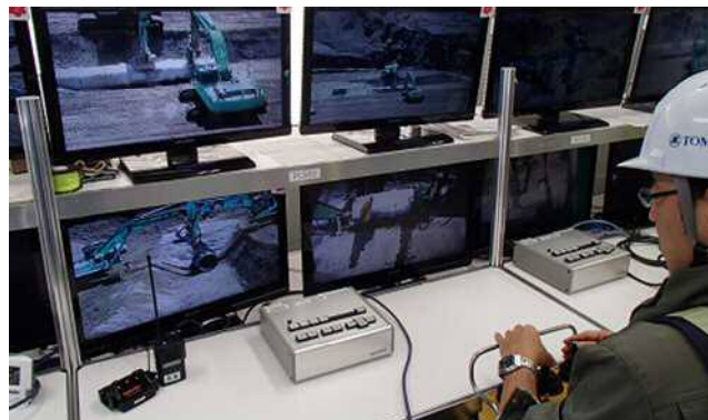
写真-2 無人化施工の状況(操作室)
