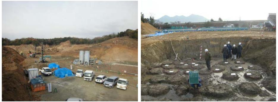
写真-2 深層混合改良施工状況(左)と地盤改良完了状況(右)
