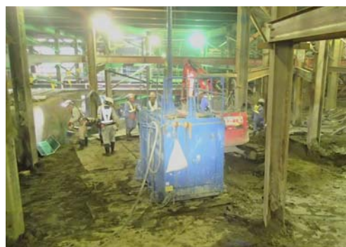
写真2 高圧噴射攪拌工施工状況
