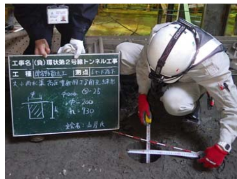
写真4 先行削孔出来形状
