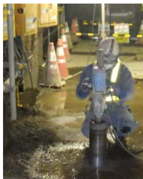
写真3 先行削孔
