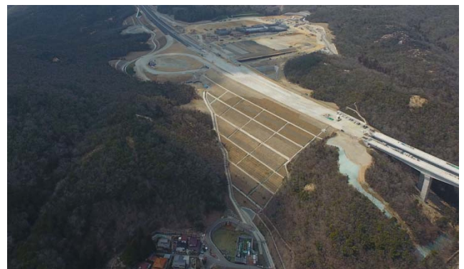
写真-1 宝塚北 SA 状況写真
