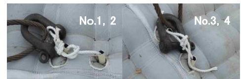
写真-3 安全ロープ取り付け方法
