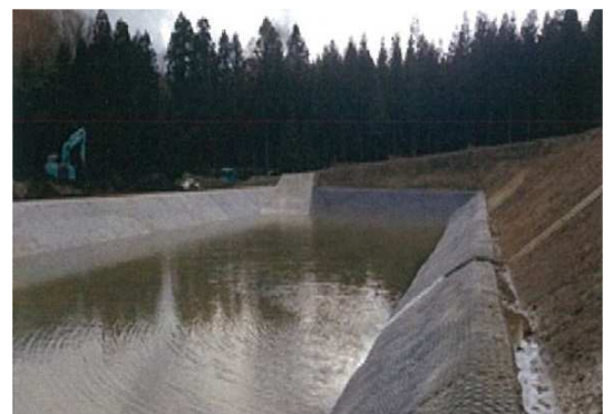
写真-1 布製型枠工によるため池の法面保護
