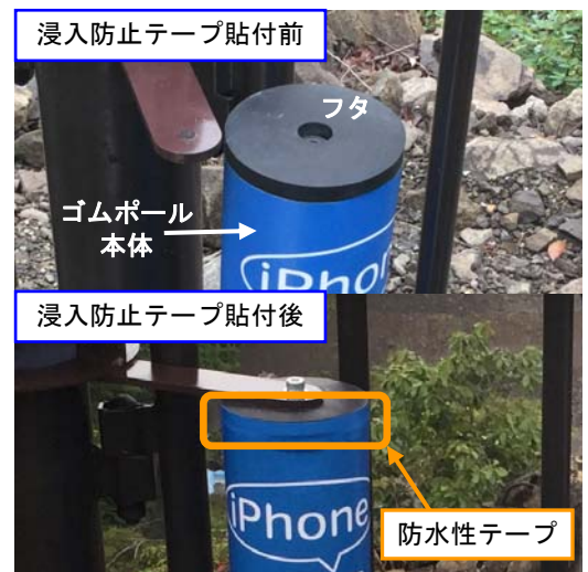
写真-5 ゴムボールの雨水等浸入防止対策
