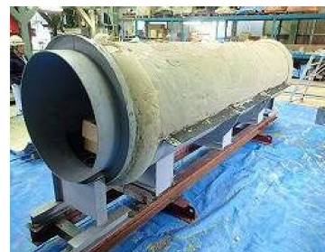
写真2 硬化後の充填状況
