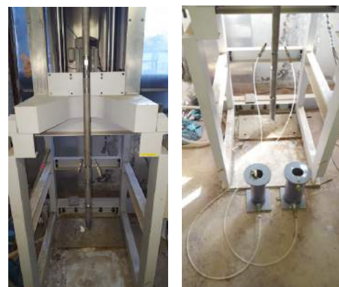
図-2 掘削機及び注入装置
