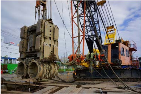
写真-2 水平多軸掘削機
