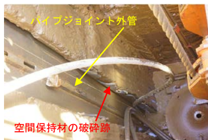
写真-9 空間保持材破砕状況
