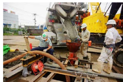
写真-6 コンクリート打設
