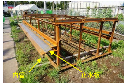
写真-4 後行エレメントの鉄筋籠
