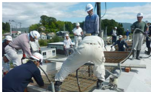
写真-1 打設状況
