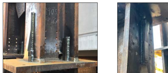
図-9 補強部材配置 (方法 2)
