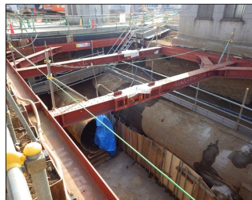
写真-1 現場状況 (H29.3 現在)
