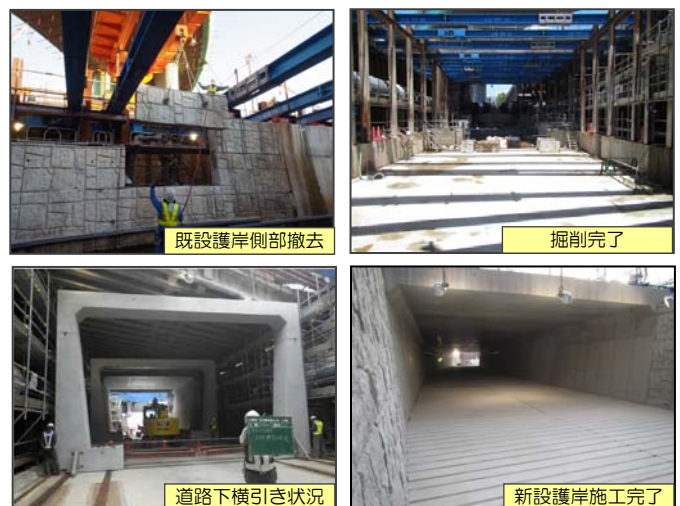
写真-2 施工状況
