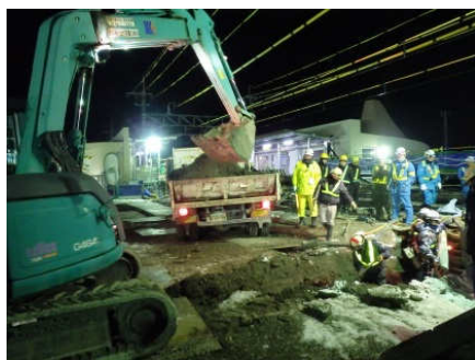
写真-4 作業ヤード側の掘削作業
