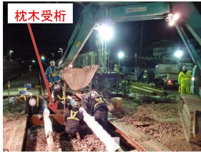
写真-8 枕木受桁設置状況
