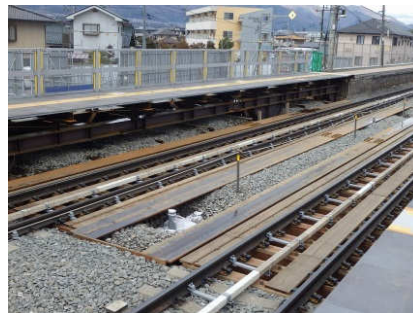
写真-9 工事桁架設完了
