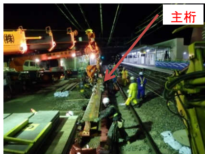
写真-7 主桁設置状況
