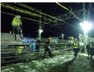
写真-2 簡素化仮ホーム
