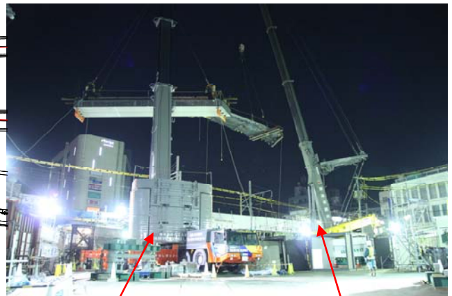
550t クレーン(UFC 桁架設) 650t クレーン(工事桁撤去)
