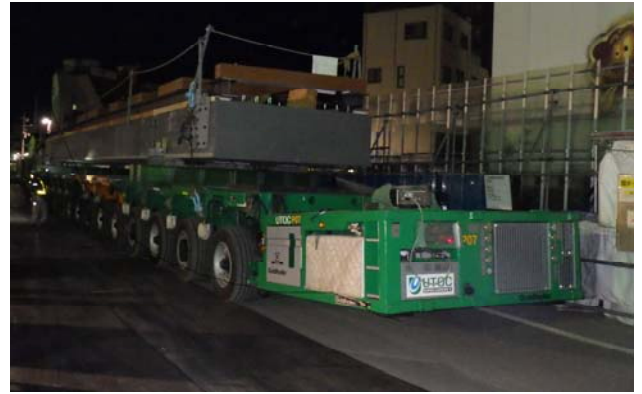
写真-1 UFC 桁運搬状況
