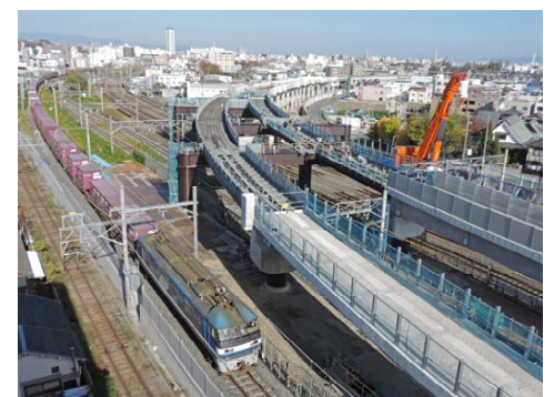
写真-2 東海道二線線路橋全景
