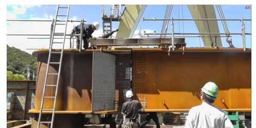
写真-1 仮受けシミュレーション
