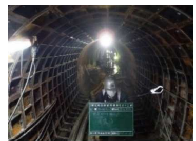
写真 3 補強後
