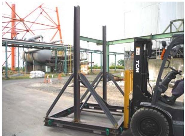
図-3.1 撤去専用の受台
