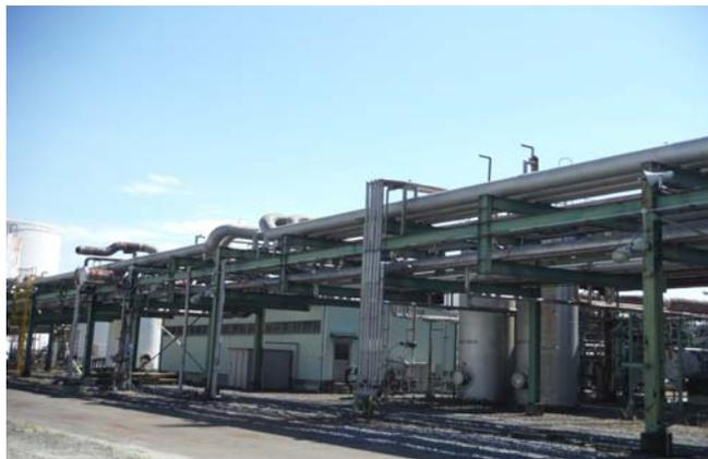
図-1.3 2段構造配管ラック
