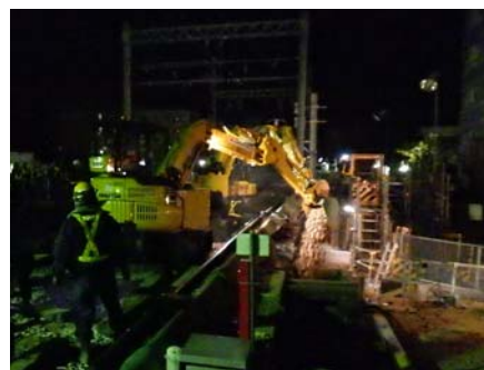
写真-3 上り線道床掘削の状況
