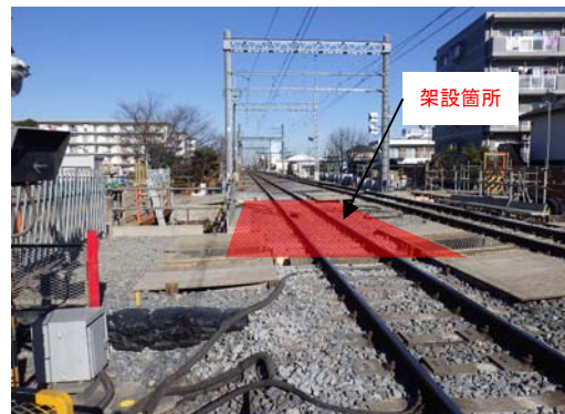
写真-2 下り線側工事桁の架設箇所
