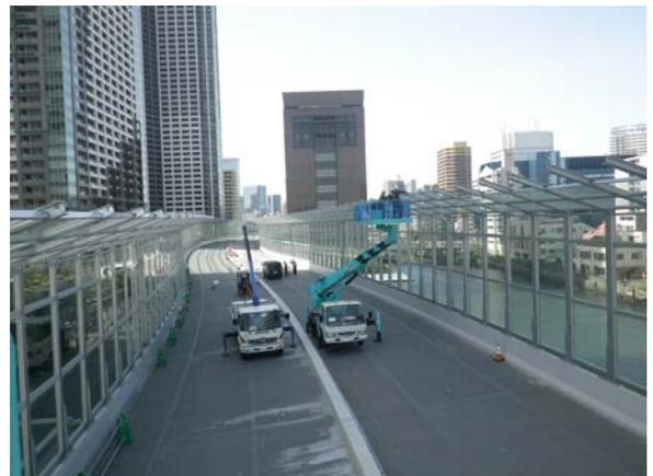
写真-1 遮音壁施工状況
