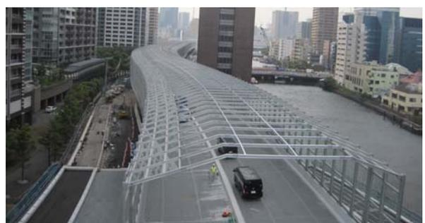
写真-4 遮音壁完成写真
